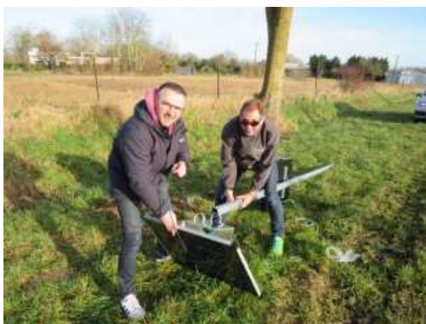
Le montage des éléments au sol
