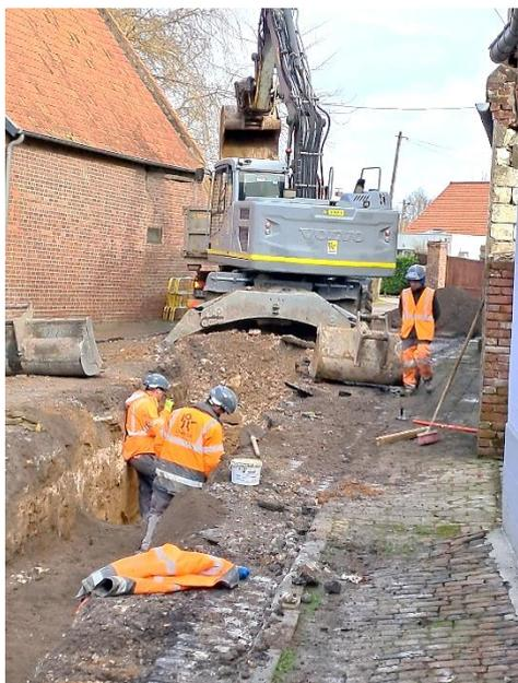
Les travaux suivent leur cours normalement et le calendrier prévisionnel est respecté. Actuellement, l'installation du réseau principal des eaux pluviales est en passe d'être terminée. Les travaux de démontage de la route et des trottoirs vont être entrepris, ainsi que la pose des éléments de la structure de tamponnement sur la place.
